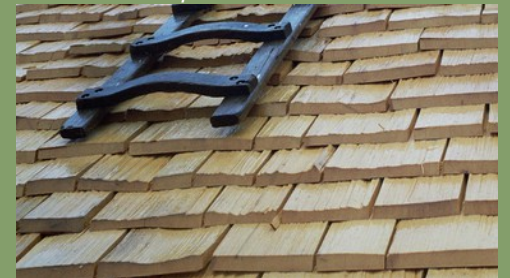
... und neuen Holzschindeldach
